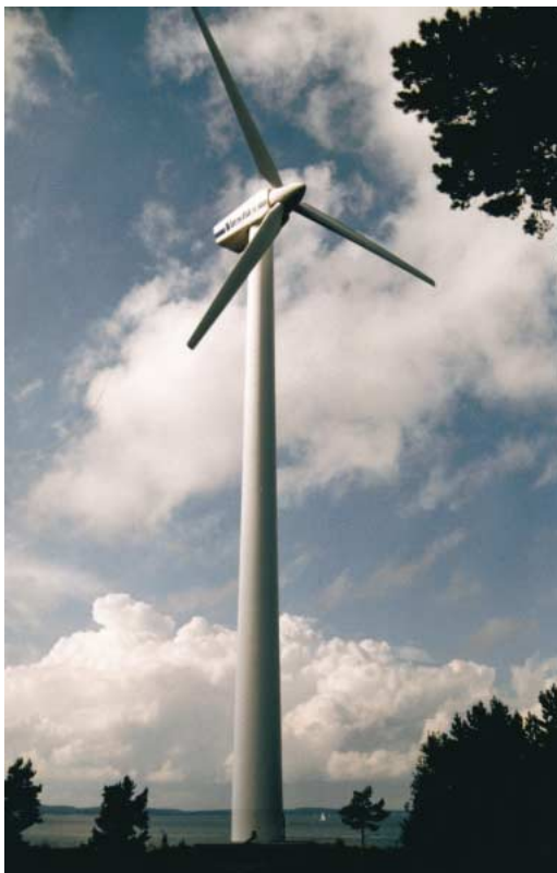
Skärgårdskraftverket sett inifrån öns skogsbryn.
