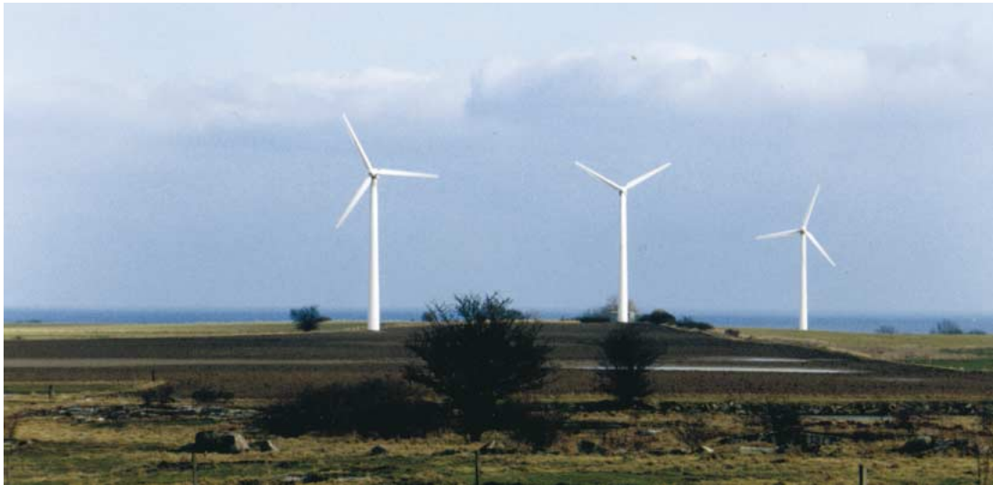
Tre vindkraftverk i rad. Turbinhusen ligger inte i helt i rät vertikallinje p.g.a. topografen.
