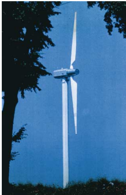
Maskinhuset 78 m över marken
