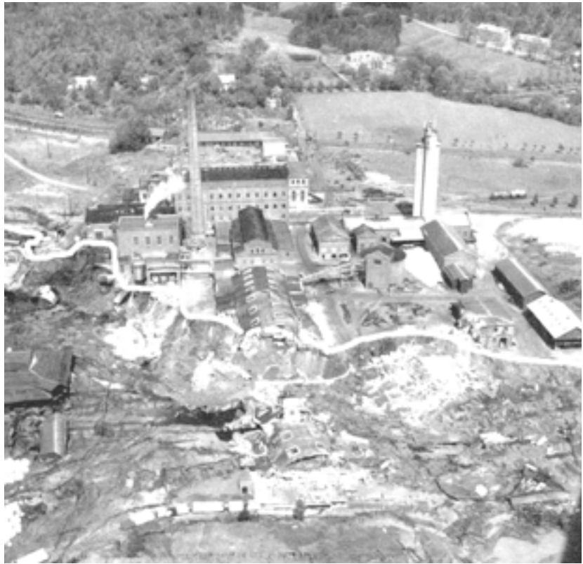
Bild 4.2 Götaskredet. Vy över industriområdet, med markerad skredbrant
