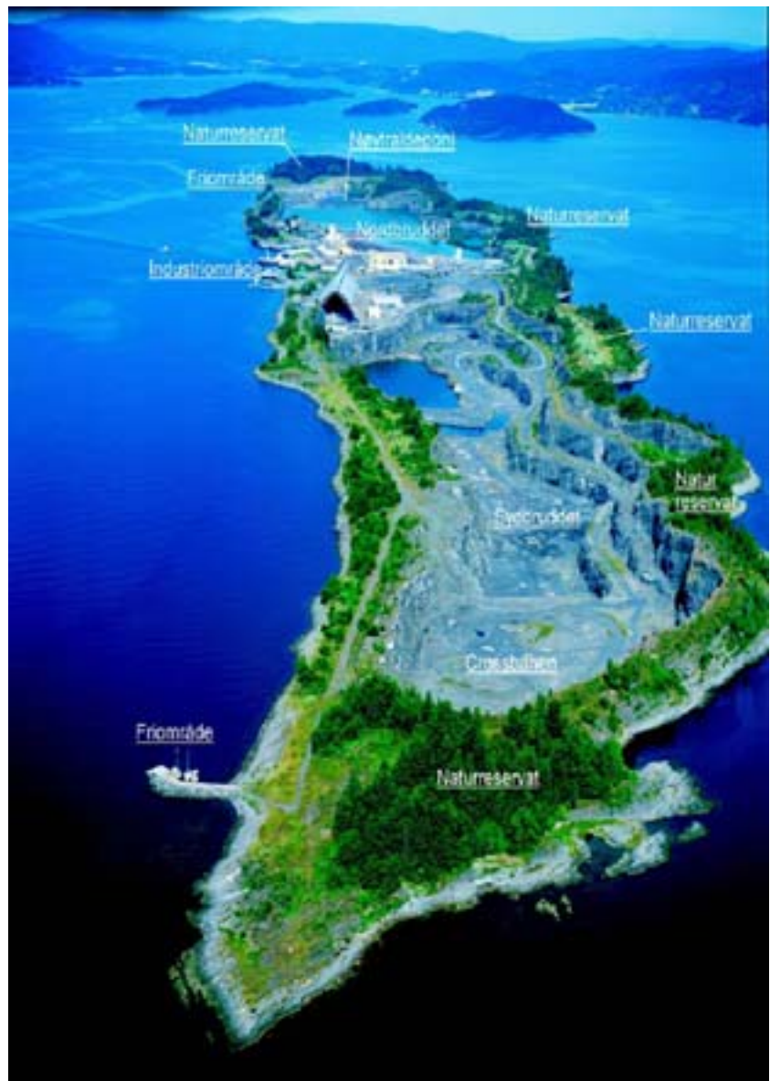
Figur 8 Orienteringsbild över Langøya, bild från NOAHs rehabiliteringsplan
