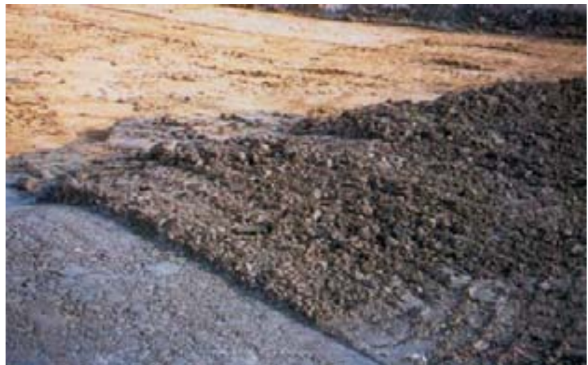
Figur 9 Lermaterialet ("Clay noodles") i första lagret före kompaktering
