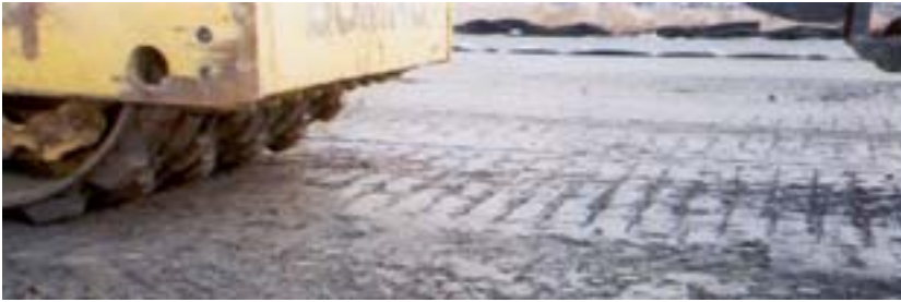
Figur 10 Kompaktering av Friedland Ton med hjälp av en vibrerande pad-foot BOMAG-vält
