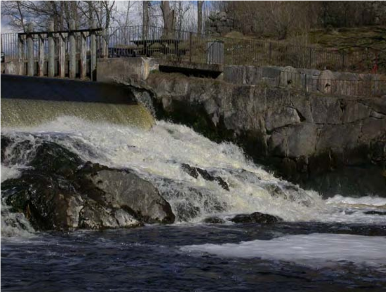
Hålldammar utgör vandringshinder för vattenorganismer och orsakar ofta för låga lågvattenflöden nedströms dammen.
