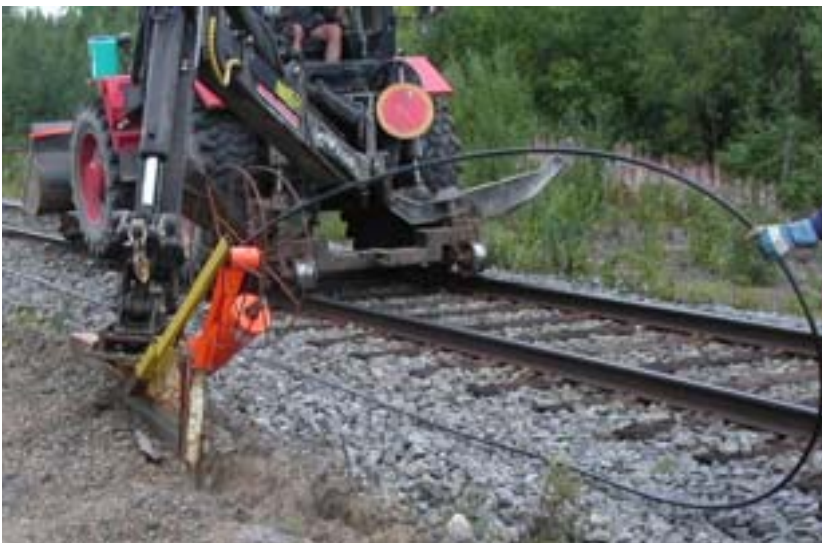
Bild 3 Foto på traktor som plöjer ner kabel längs banvallen
