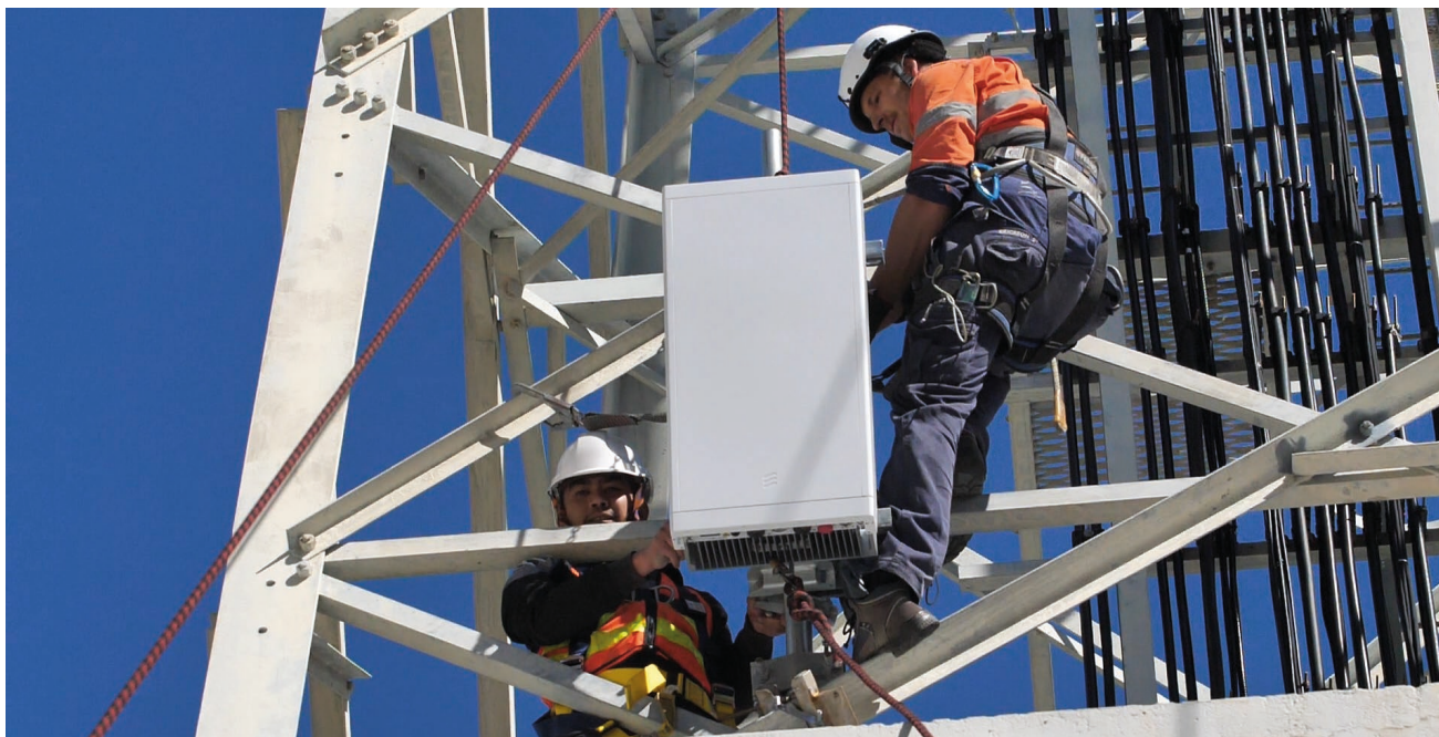
Installation av Ericssons 5G-radiomaster vid Telstras Innovation Centre i Australien. Källa: Ericsson.
