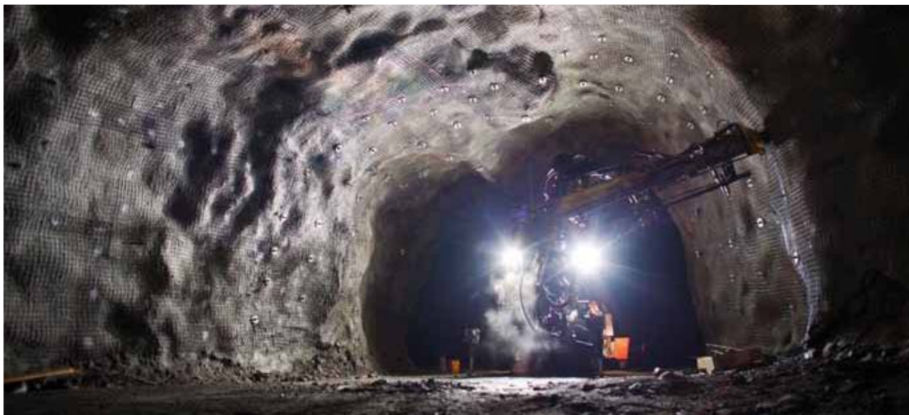
Malmen finns i malmkropparna under Kiruna och Malmberget där LKAB brutit järnmalm under mer än hundra år. Eftersom malmkropparna går in under bebyggelsen innebär en ökad gruvdrift, om den sker utan åtgärder, en risk för samhällena. Här förstärks en del av berget för att klara malmbrytningen. Foto: LKAB
