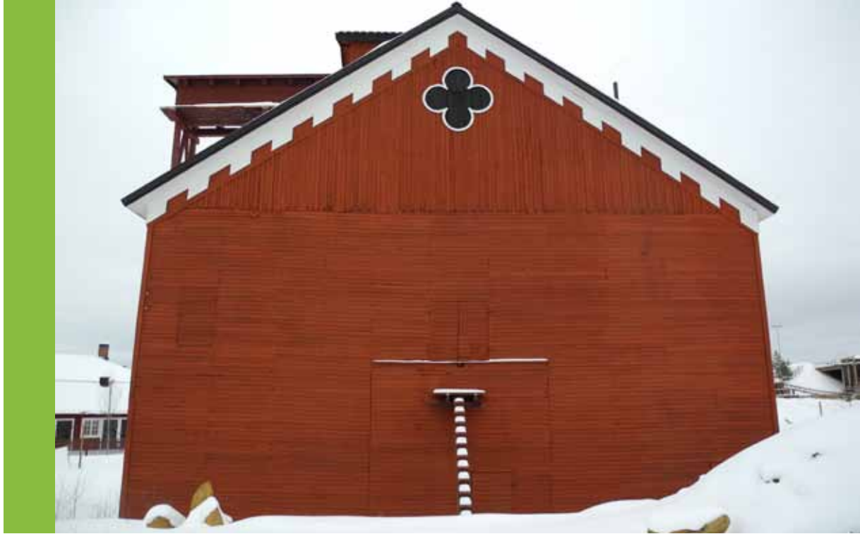
"Creutz spelhus vid Falu Gruva byggdes 1855 och är Sveriges enda bevarade spelhus för uppföring (hissning) av malm från flera olika schakt." Foto: Falu Gruva.
